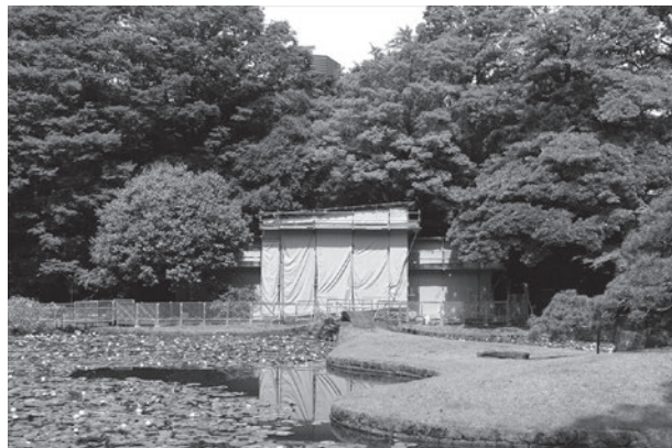
写真6 仮囲いと素屋根
