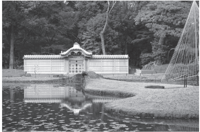
写真1 復元した唐門及び袖堀（正面全景）
