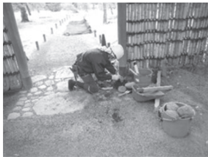
最も人通りが多い庭門下園路の補修
